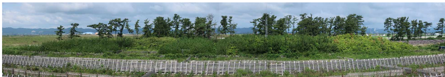
防潮堤天端からの 全景写真
