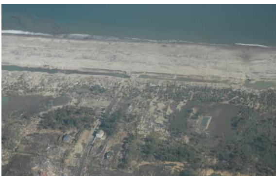
潮害防備保安林の被災(宮城県岩沼市)
