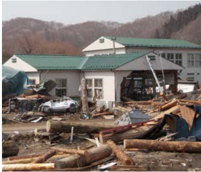
津波により全壊した三陸北部署の庁舎 (岩手県宮古市)
