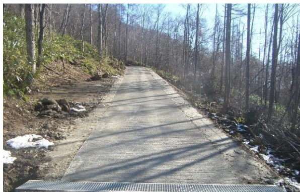
林道（林業専用道）開設
