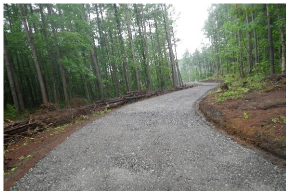
林道（林業専用道）開設
