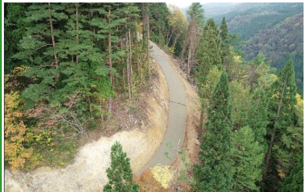
林道（林業専用道）開設
