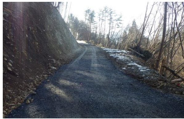
林道（林業専用道）開設
