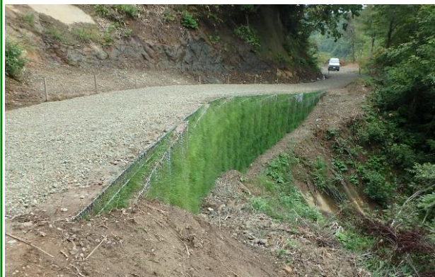
林道（林業専用道）開設
