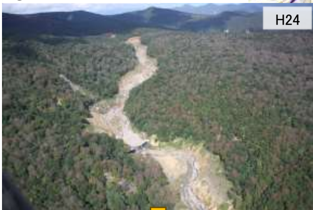
【①ドゾウ沢 復旧状況】
