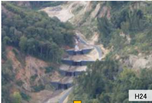
【①シヅミクキ沢 復旧状況】
