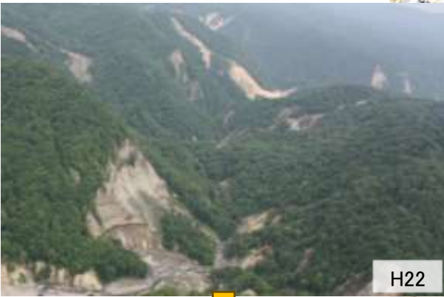
【①湯ノ倉 復旧状況】
