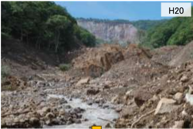
【①産女川上流 溪間工整備状況】
