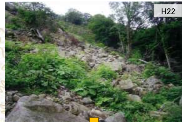
【②真湯 復旧状況】
