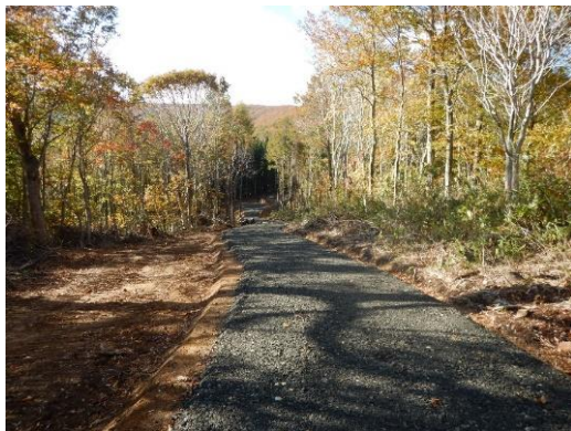
林道（林業専用道）開設
