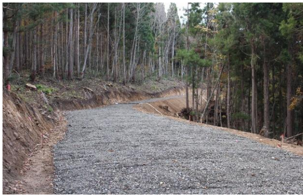
林道（林業専用道）開設
