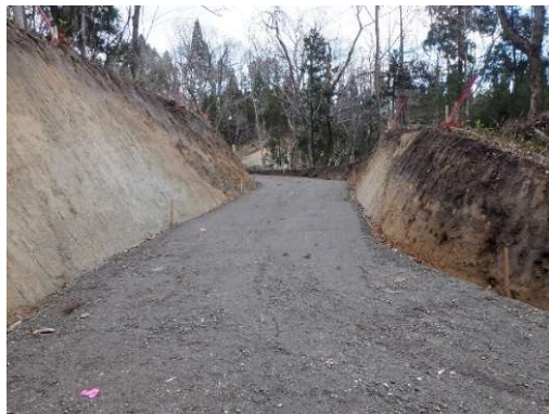
林道（林業専用道）新設
