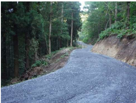
林道（林業専用道）開設
