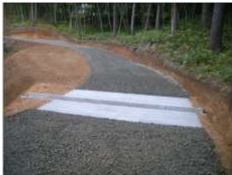
林道（林業専用道）開設
