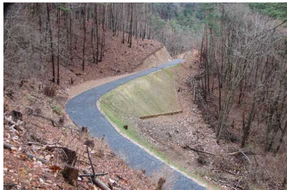
林道 (林業専用道) 開設
