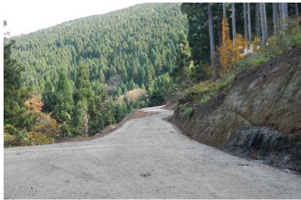
林道（林業専用道）開設
