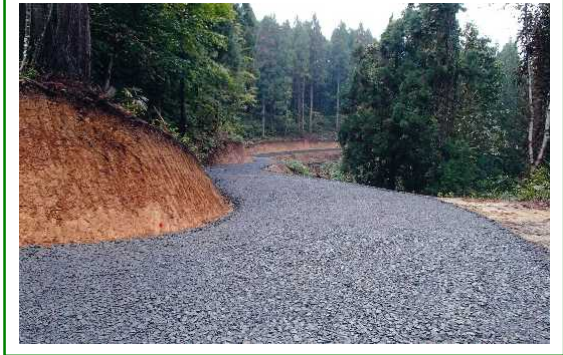
林道（林業専用道）新設
