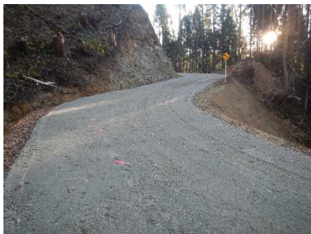
林道（林業専用道）新設
