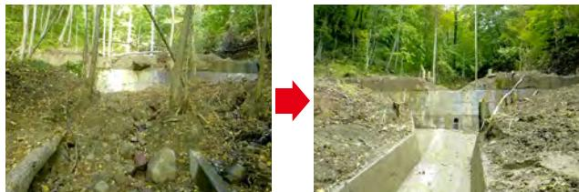
土砂の流出により流路が閉塞したため、緊急応急工事により土砂を撤去
