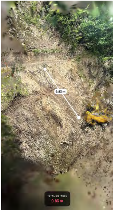
LiDAR機能による施工状況確認
