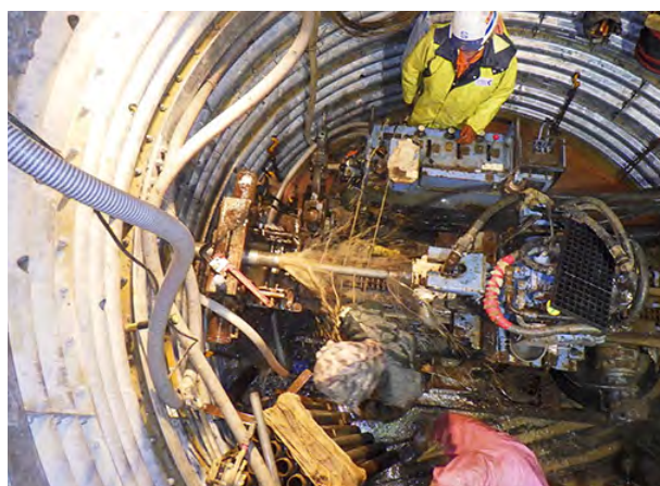
横穴を掘削している状況
