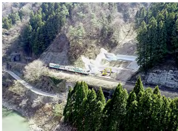
治山ダム工（阿武隈急行線）
