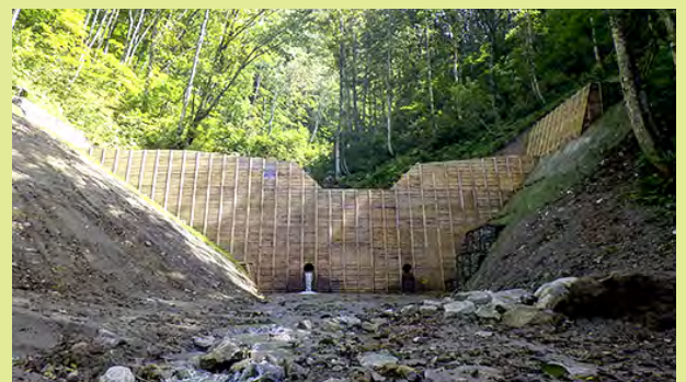
土砂流出対策(深間工) 渓流の侵食や崩壊を防止するとともに、下流への急激な土砂流出を抑止する(山形森林管理署：山形県西川町)
