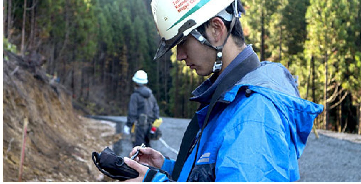
測量作業の様子
