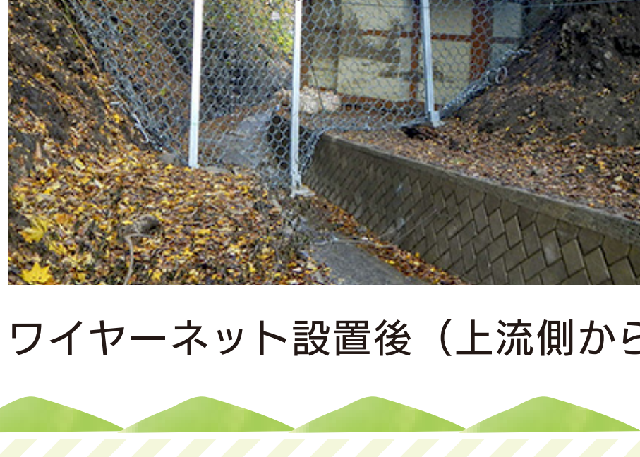
ワイヤーネット設置後（上流側から）
