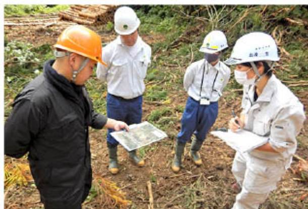
立木の伐採状況を確認
