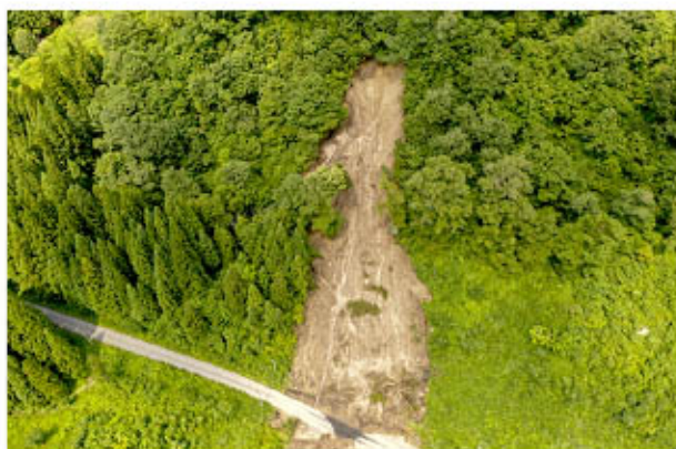
山腹崩壊箇所（舟渡森林事務所管内）
