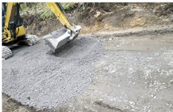
鉄鋼スラグを敷き均しする様子
