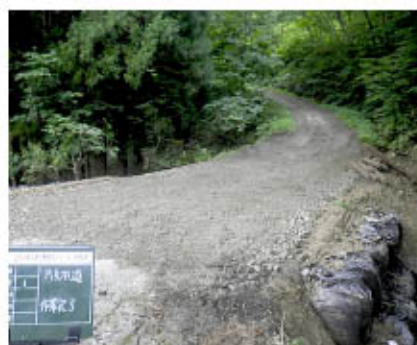
チャーターによる現道復旧
