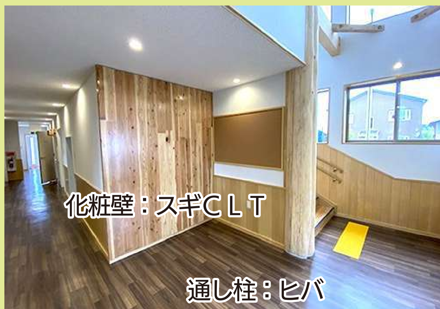
1階ホール（スギCLT材・地場産ヒバの丸太柱）
