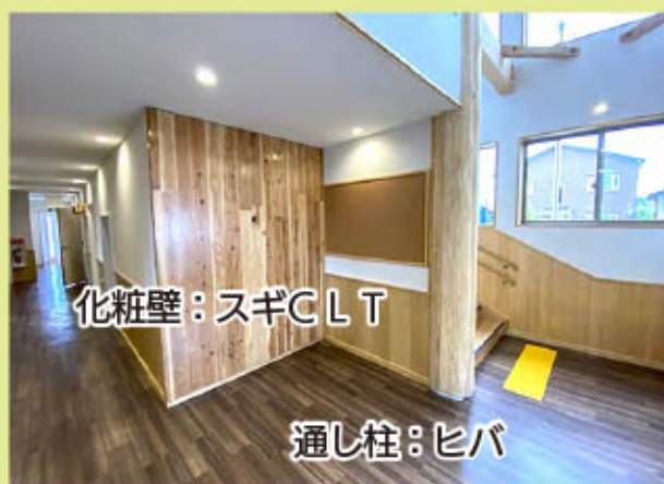
1階ホール（スギCLT材・地場産ヒバの丸太柱）
