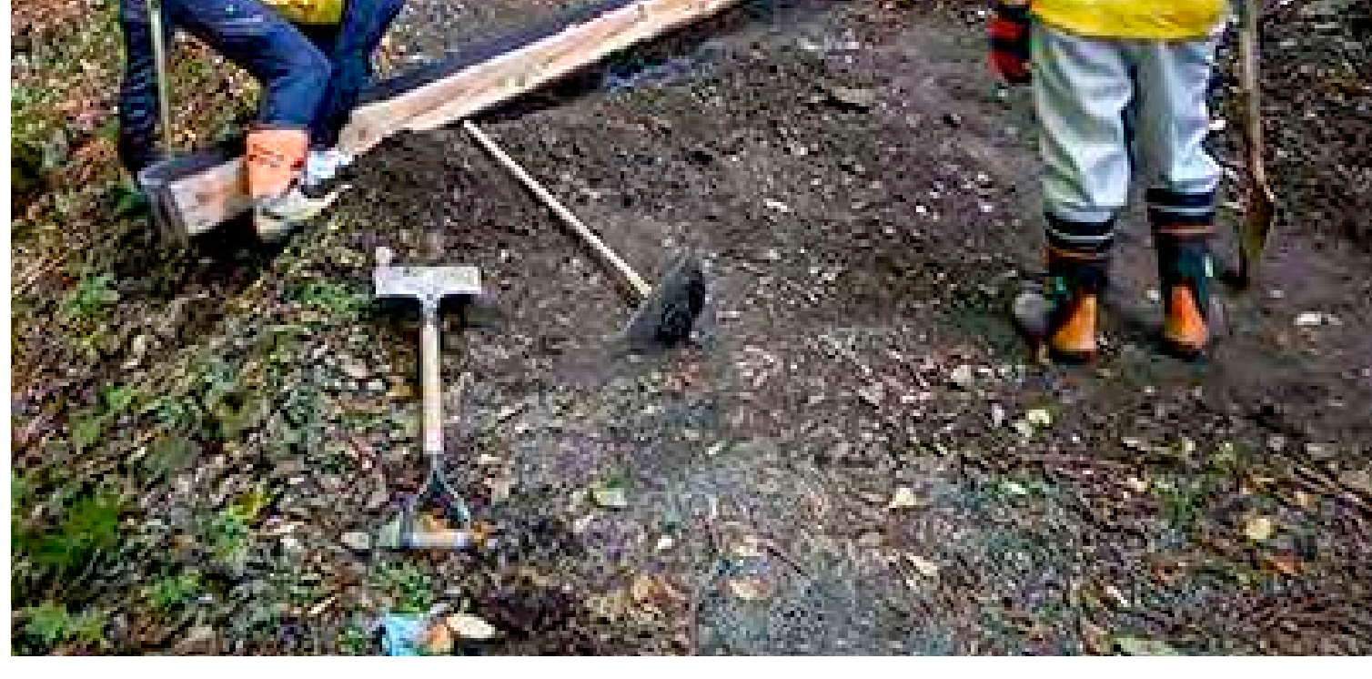
木製路面排水工の施工
