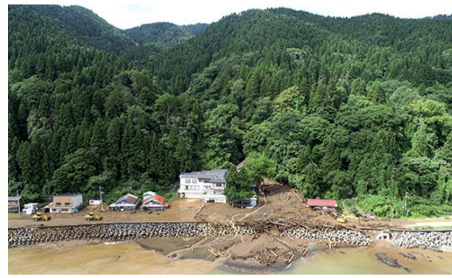
令和4年8月大雨による被災状況 (青森県外ヶ浜町)
