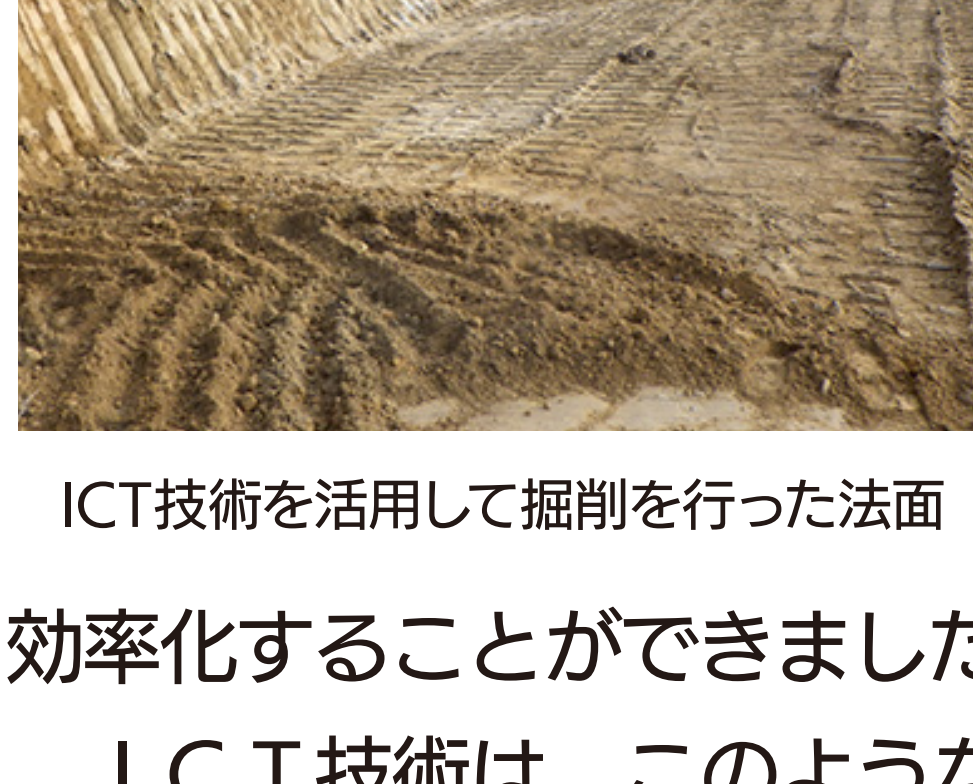
ICT技術を活用して掘削を行った法面
