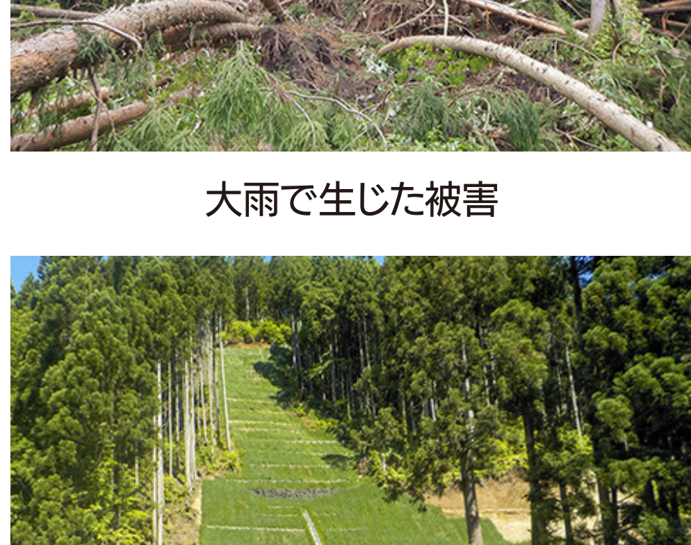
大雨で生じた被害
