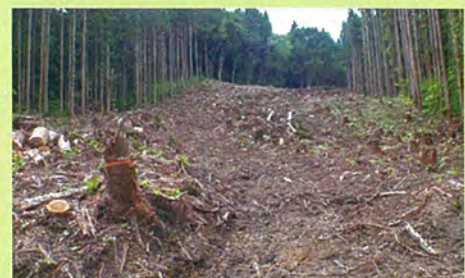
一貫作業事業地（岩手北部署管内）
