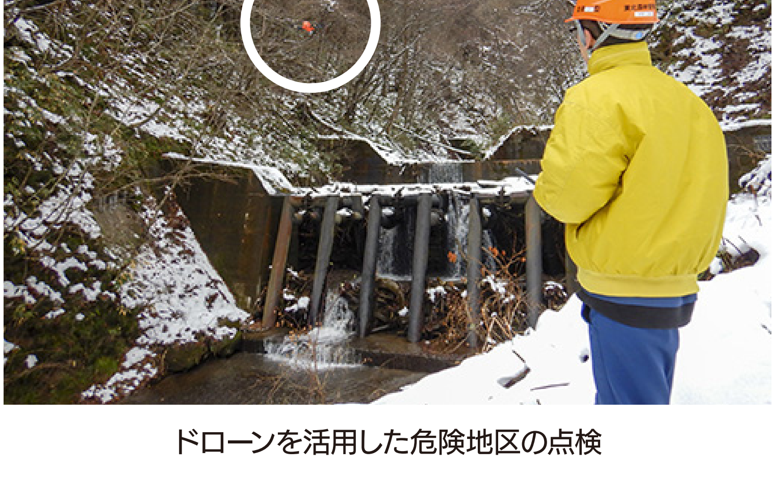
ドローンを活用した危険地区の点検
