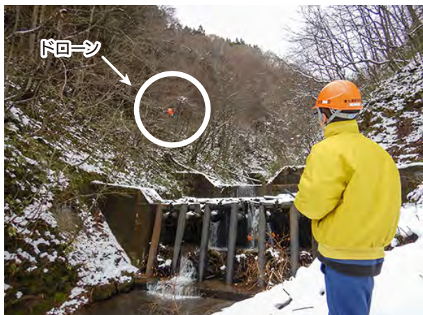
ドローンを活用した危険地区の点検
