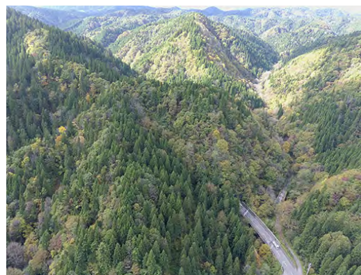
ドローン空撮による被害状況の確認
