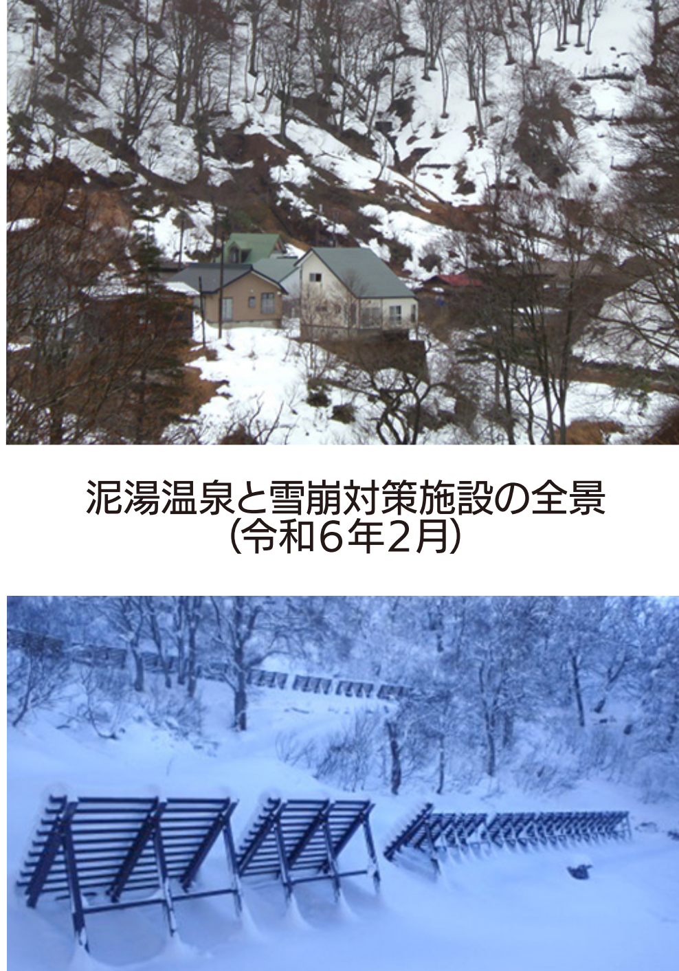
泥湯温泉と雪崩対策施設の全景 (令和6年2月)
