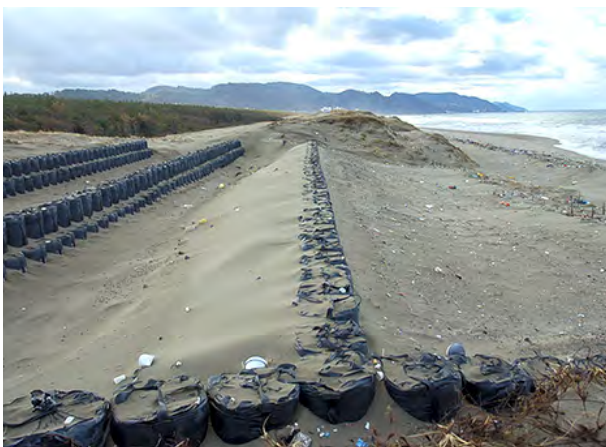
最前線部における砂丘造成工
