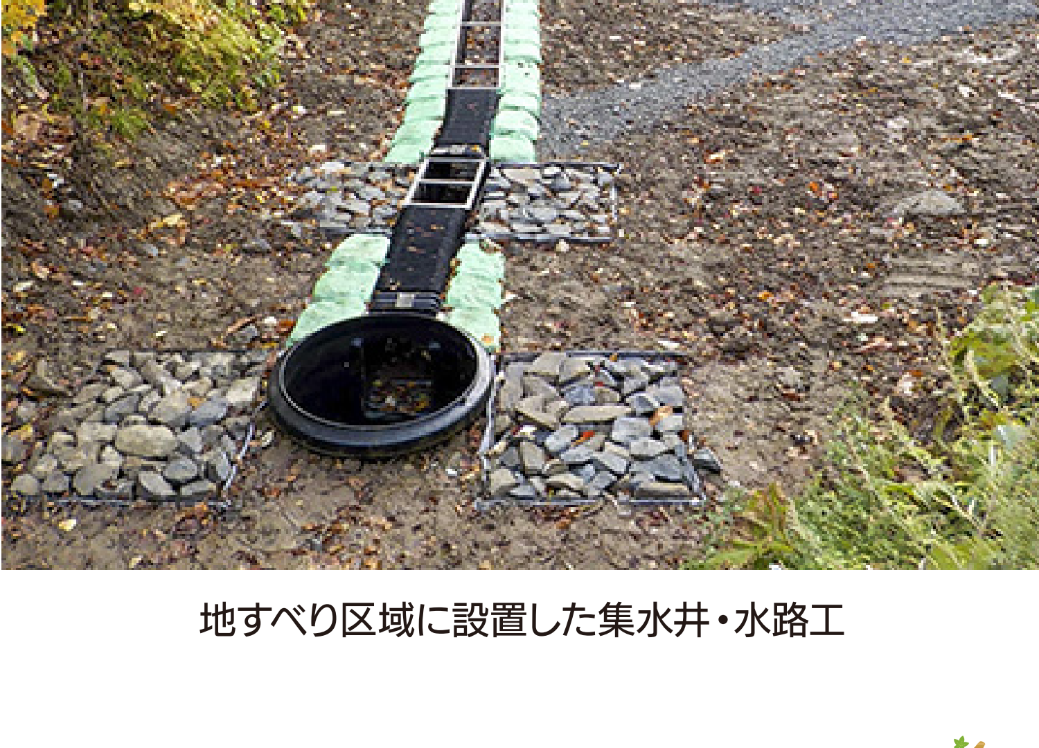
地すべり区域に設置した集水井・水路工
