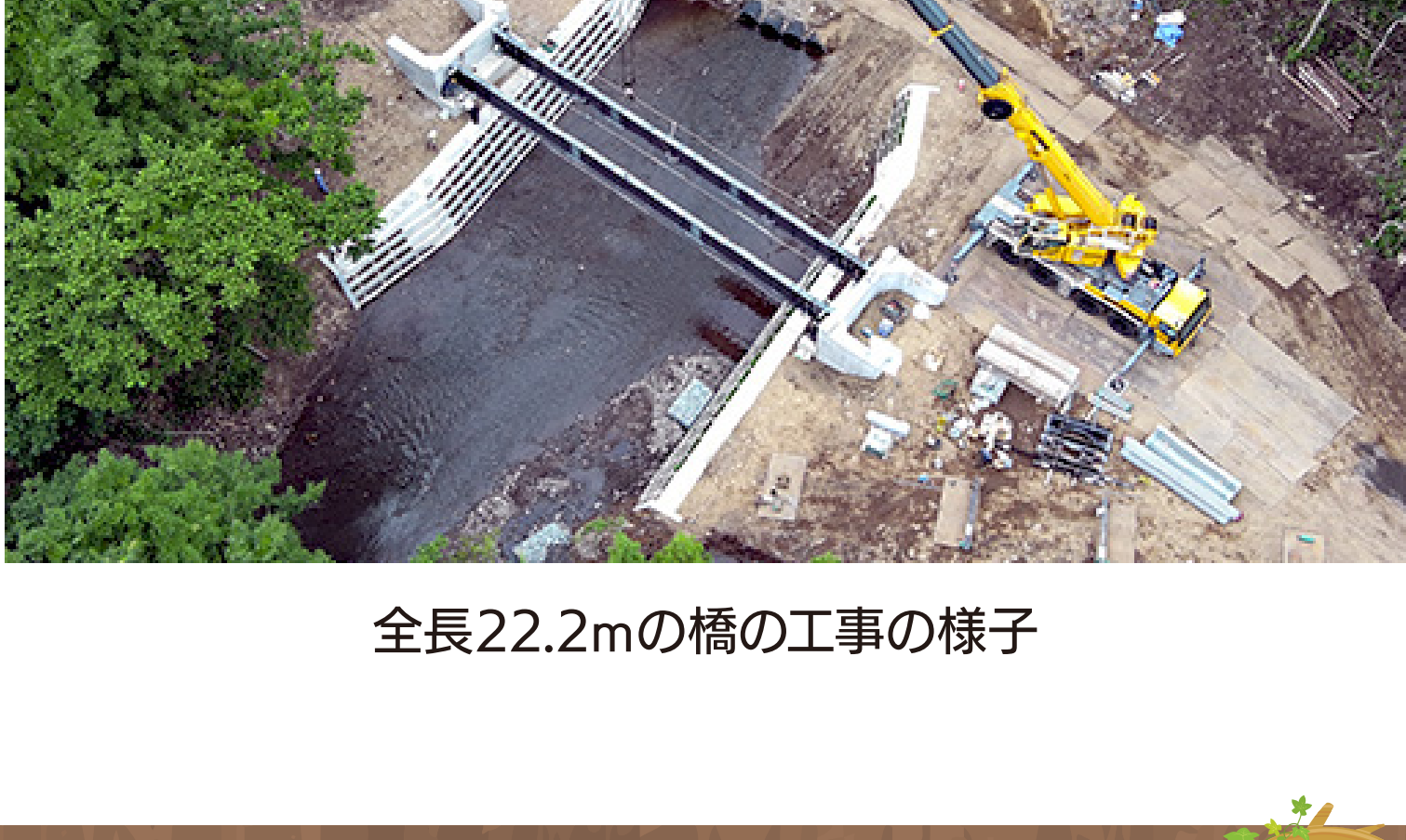
全長22.2mの橋の工事の様子
