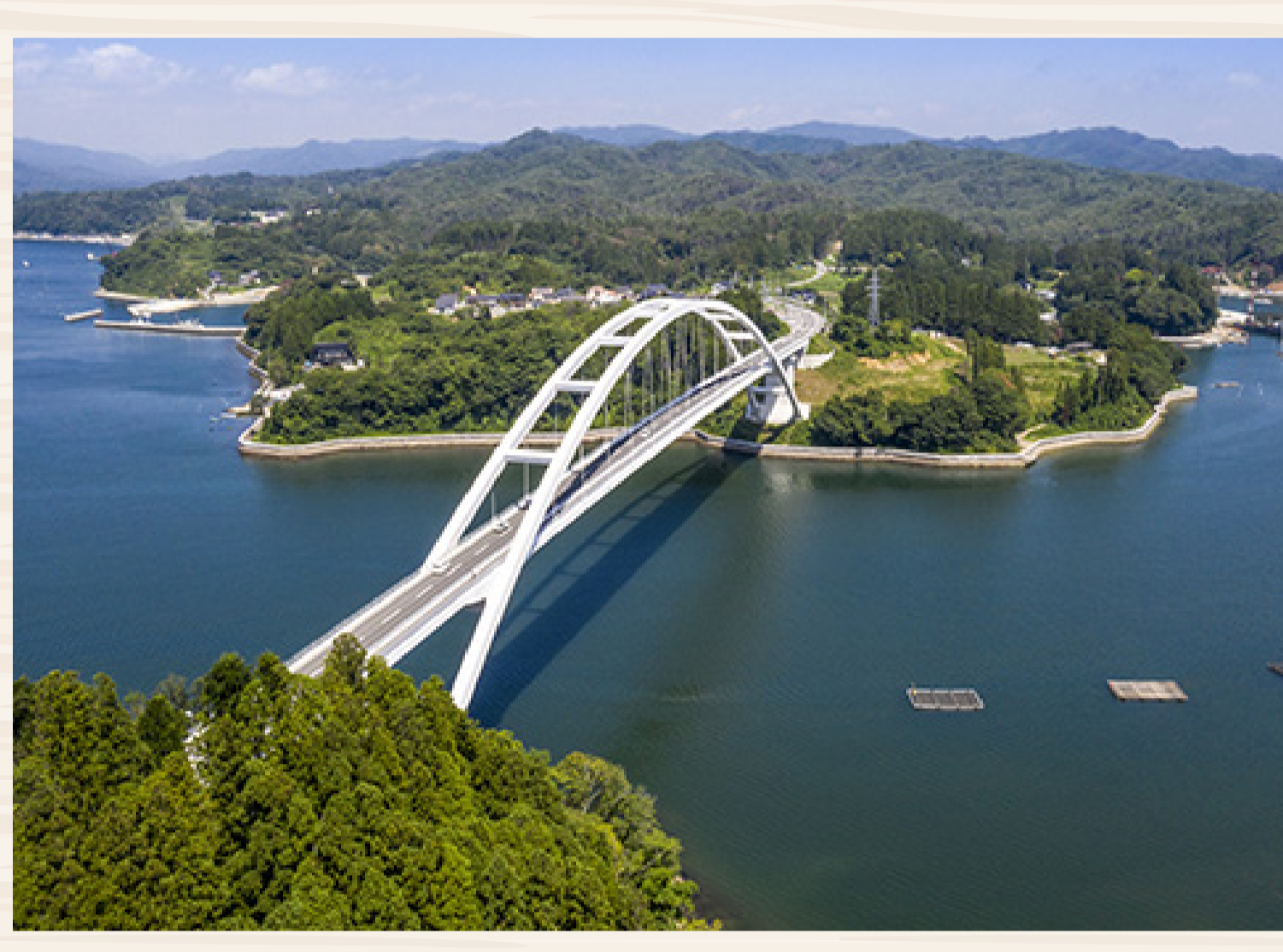
気仙沼大島に架かる「大島大橋」
