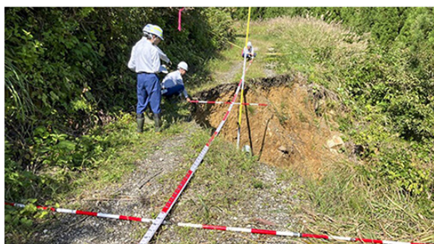
路体の決壊現場における実習
