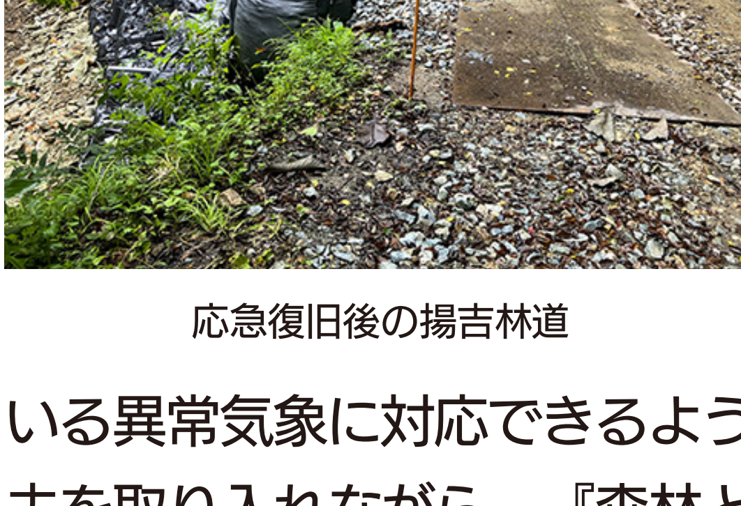
応急復旧後の揚吉林道
