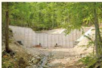
木製残存型枠を使用した治山事業（青森署）
