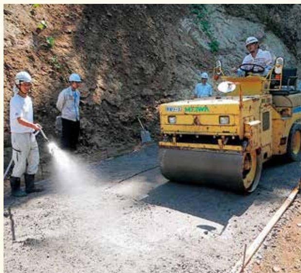
(写真-3) 施工写真 (散水・転圧)
