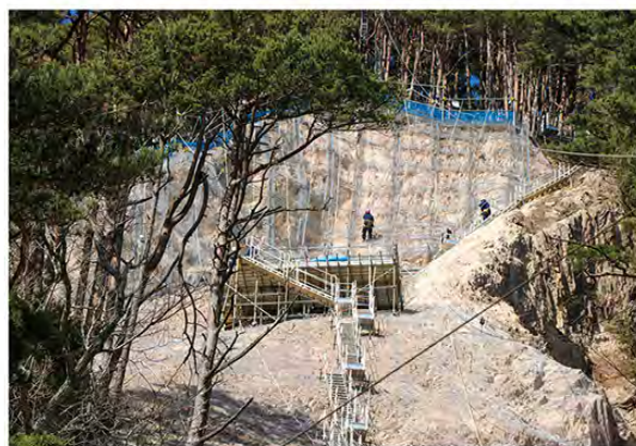
写真4 実測位置（前壊地上部）
