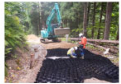
路盤補強工法（ぬれれ軽減対策）
