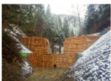
治山事業への木材の利用
