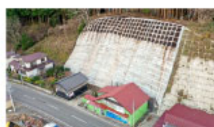
法枠工【青森県外ヶ浜町】
