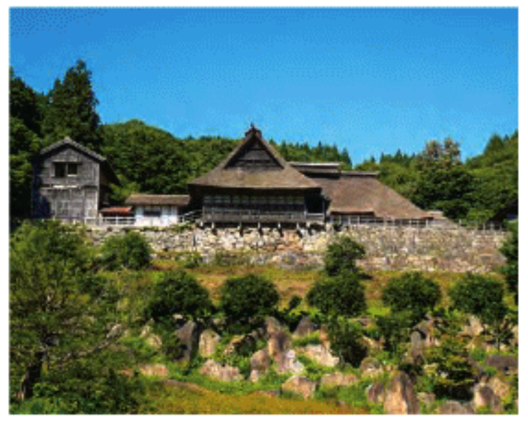
千葉家(修復工事前)
