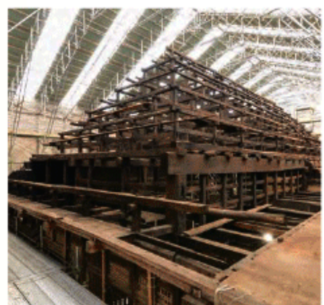
修復工事中の千葉家
