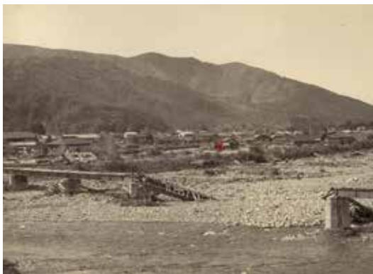
流された早瀬川の森林鉄道の橋梁
