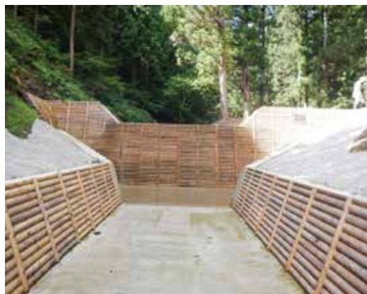
木製残存型枠（治山事業）
