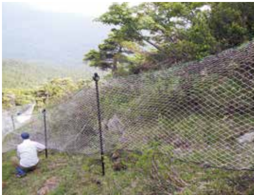
早池峰山高山帯での高山植物保護のための柵設置 (ニホンジカ被害対策)
