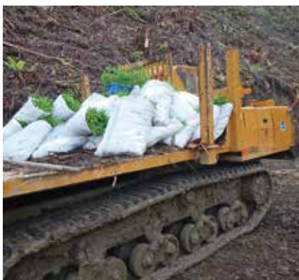
フォワードによる効率的な苗木の運搬 (一貫作業システム)
