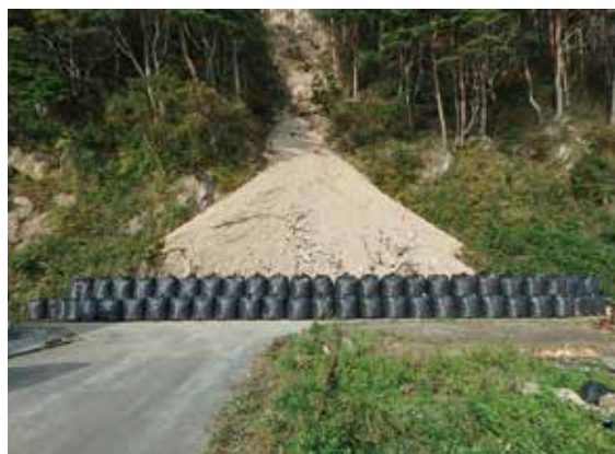
台風第19号災害への応急対策（岩手県久慈市）
