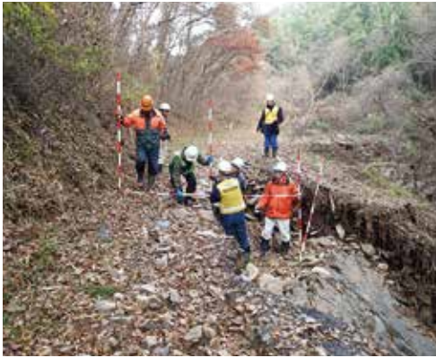
令和元年台風第19号による林道被害への林道施設災害支援チームの派遣（宮城県登米市）
