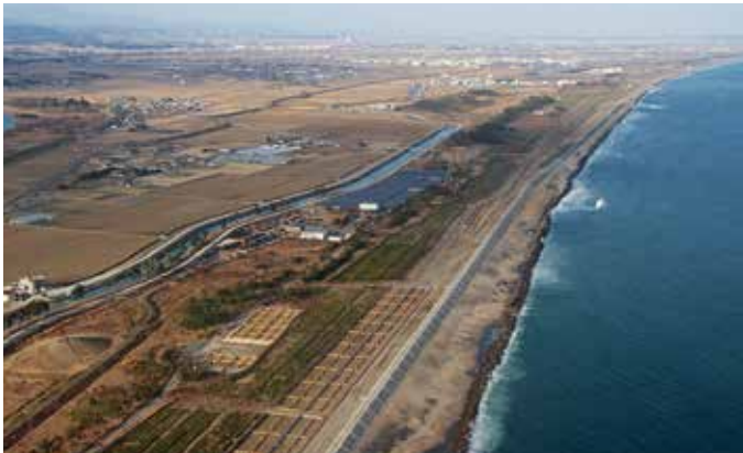
海岸防災林の復旧状況（仙台湾沿岸地区（令和元年12月19日））
