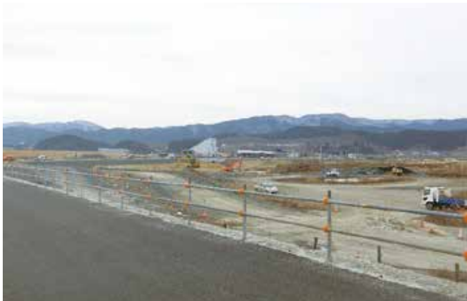
「高田森林事務所跡地（右奥の重機付近）」
