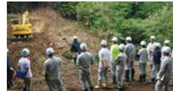
鋼製スリットダム工の施工状況説明
