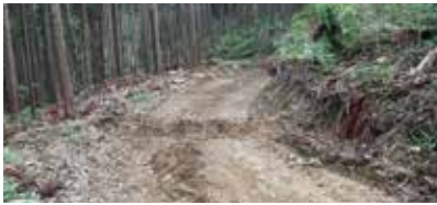
森林作業道の施工状況
