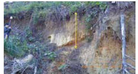
写真3：切土法面にみられる厚い土壌 黄色の矢印の部分が土壌の厚さ（約2m）
