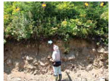
写真2：切土法面にみられる薄い土壌と厚い石礫層 白色の矢印は赤白ポール、黄色の矢印はスギの植栽木
