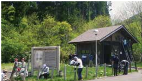
トイレ、看板のペンキ塗り
