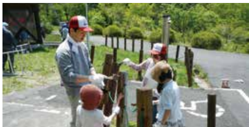
柵柱のペンキ塗り
