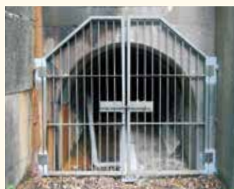
排水トンネルの入口
