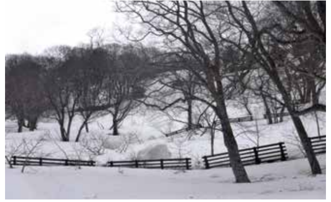
写真3 既存のなだれ防止柵
