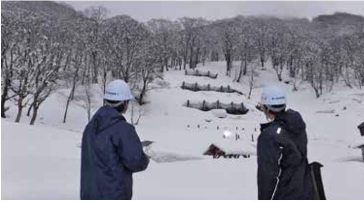
写真8 無人航空機を活用した点検
